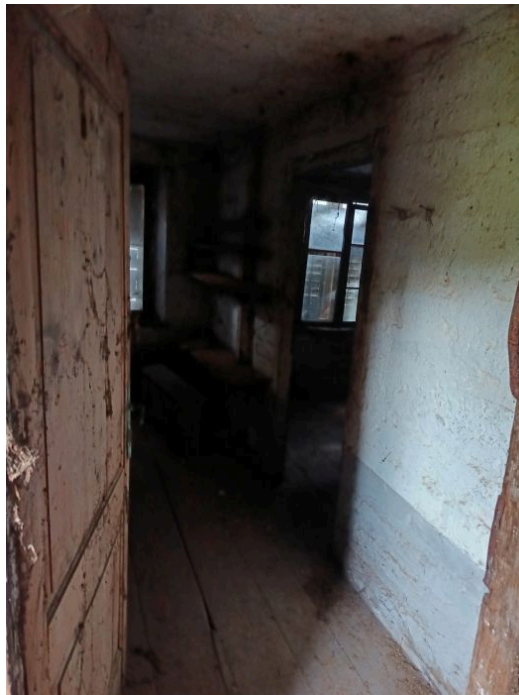
Vista interna (deposito/granaio - piano primo) - p.ed. 545 - C.C. Pieve Tesino
