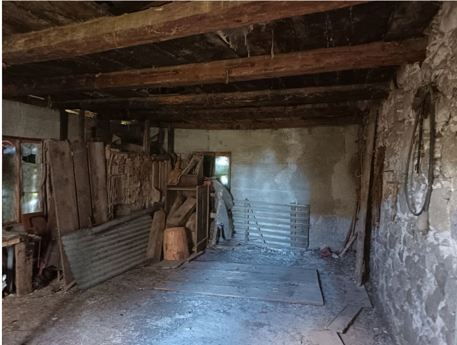
Vista interna (deposito attrezzi agricoli - piano primo) - p.ed. 543 - C.C. Pieve Tesino
