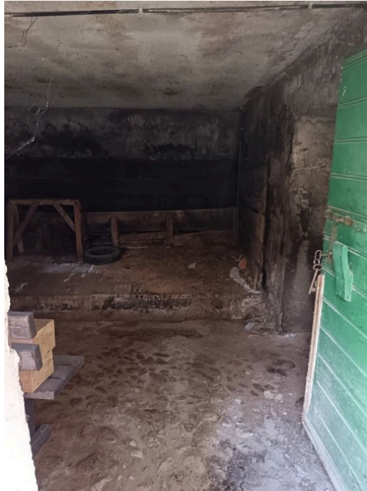
Vista interna (stalla - piano terra) - p.ed. 545 - C.C. Pieve Tesino
