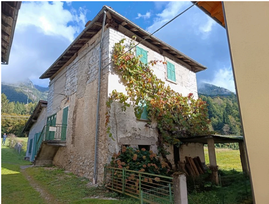
Vista esterna (sud) - p.ed. 543 - C.C. Pieve Tesino
