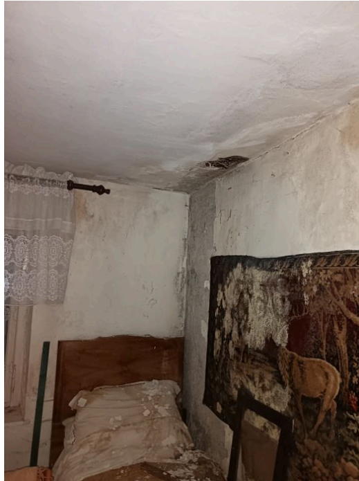
Vista interna (camera 1 - piano primo) - p.ed. 543 - C.C. Pieve Tesino
