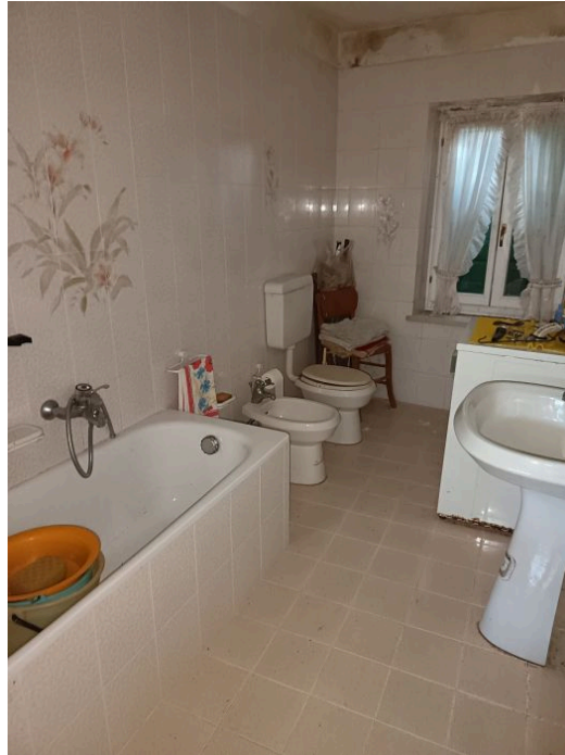
Vista interna (bagno - piano primo) - p.ed. 543 - C.C. Pieve Tesino
